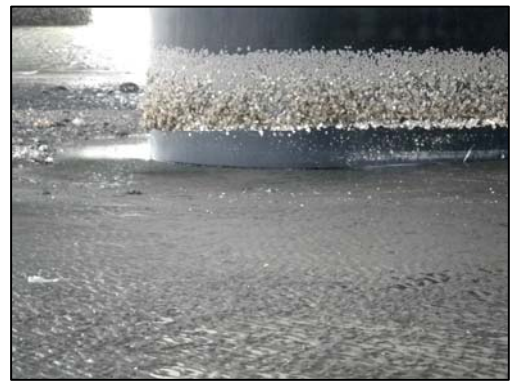
江戸川放水路湾岸道路橋脚(露出 30cm)
