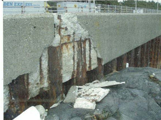
⑦コンクリート剥離
