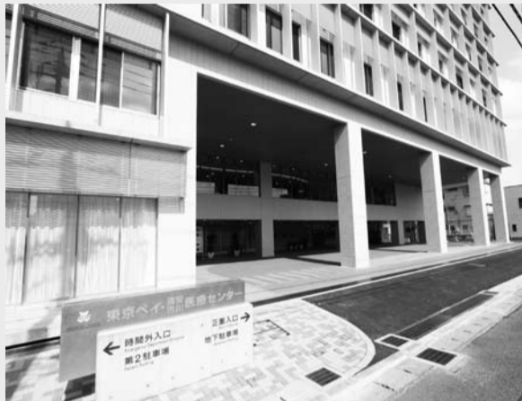
▲3月に完成した新病棟(地上8階地下1階、延床面積約28,000㎡、鉄筋コンクリート造り)
