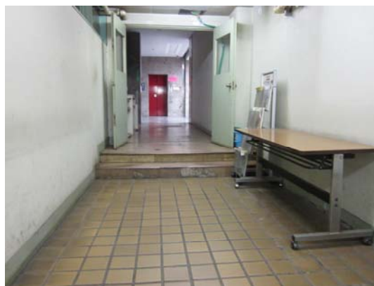
通路に生じた段差（第2庁舎内）
