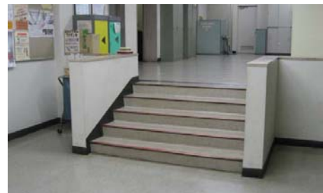
第1庁舎と第2庁舎をつなぐ階段
