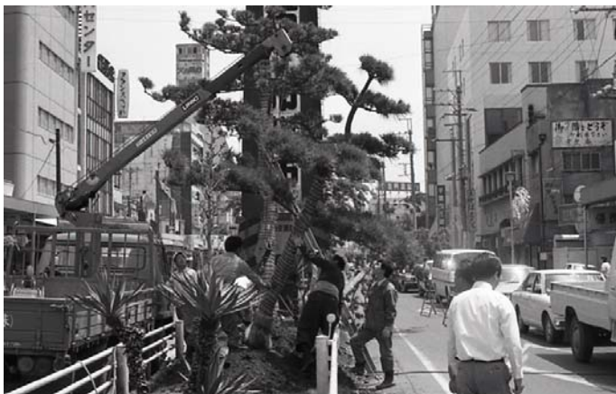
「三本松植栽工事」 昭和50年5月
