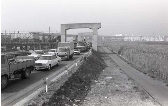
「湾岸道路(二俣高架)」 昭和55年11月
