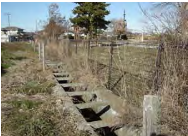
南西フェンス 2011年11月 作業前
