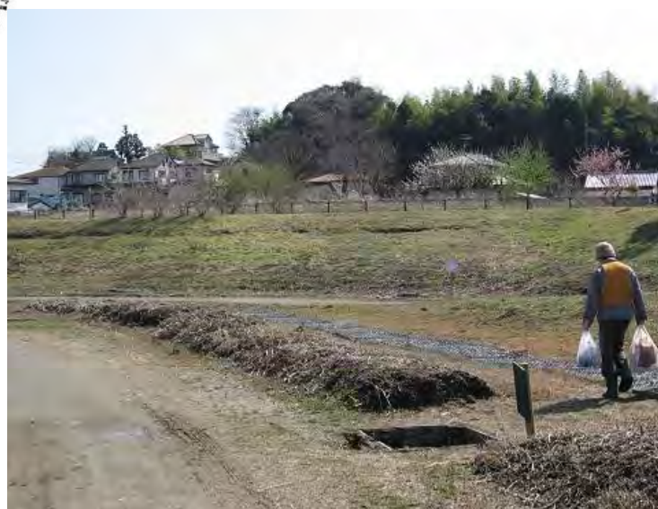
東側法面全景
