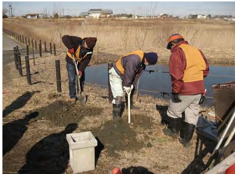
基礎打ち工事
