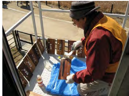
ニス仕上げ作業
