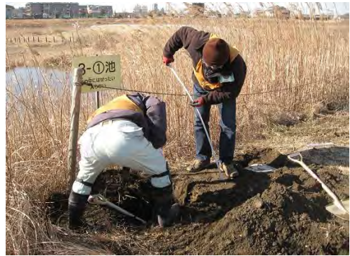
留柵設置作業
