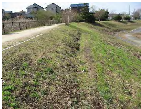
東側法面の崩落状況
