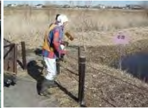
取付け杭打ち作業
