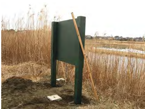
看板刈り設置(コンクリート養生中)
