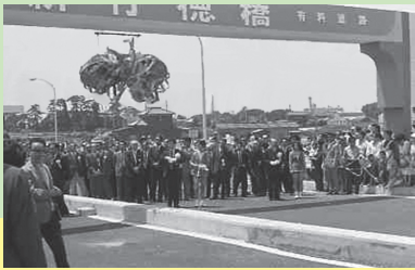
新行徳橋開通 (昭和47年)
