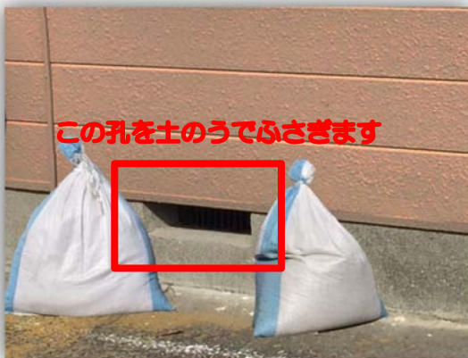
3. 換気口なども土のうで覆えば床下浸水が防げます。
