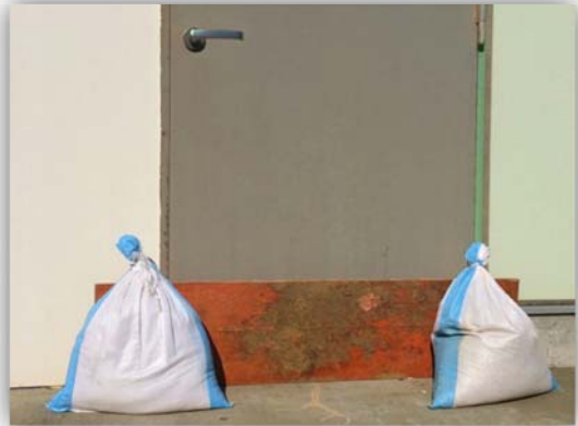
2. 土のうが少なければ板などを扉にあてて、両脇を固定しましょう。
