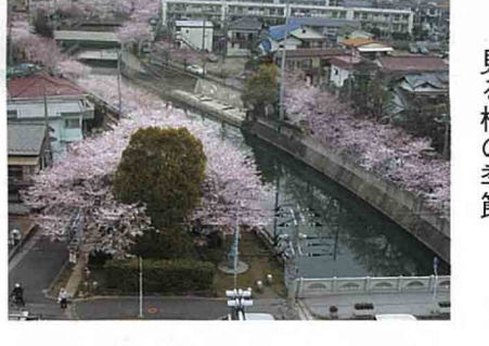
J 東消防署の屋上から見る桜の季節
