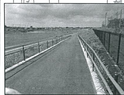
園路・坂路 (アスファルト舗装)
