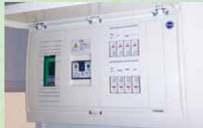
▲住宅の分電盤(写真)に増設し、地震による電気火災を防ぐ「感震ブレーカー(分電盤タイプ)」も、平成27年7月から新たにあんしん住宅助成制度の対象に。
