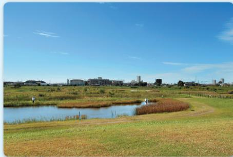
大柏川第一調節池は、大柏川を流下してくる洪水の一部を貯留して、下流域の浸水被害の軽減を図る施設で、約25万4,000立方メートルの水を蓄える機能を持っています。また、普段は水辺の魅力を引き出し、地域の交流の拠点となる緑地でもあります。
