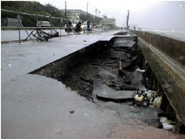
延長約50mにわたって陥没が発生 (塩浜1丁目付近、平成13年9月11日午後撮影)
