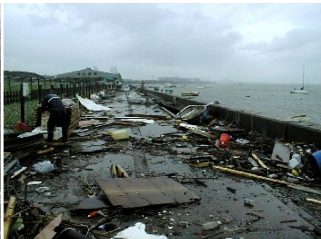
護岸に打ち上げられた不法係留のボート・イカダ類の残骸 (塩浜2丁目付近、平成13年9月11日午後撮影)
