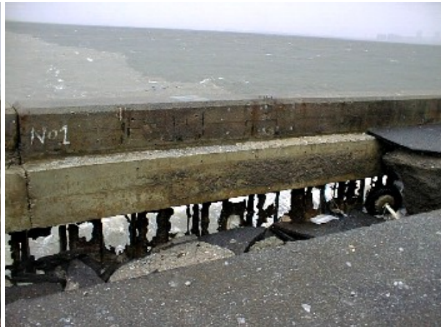
腐食で穴の空いた鋼矢板から土砂が流出 (塩浜1丁目付近、平成13年9月11日午後撮影)
