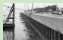
現在の直立護岸は高さ5メートル弱。県の試算によると、直立護岸は8メートル、砂浜を設けた場合の護岸は6メートルの高さが必要とされています。
