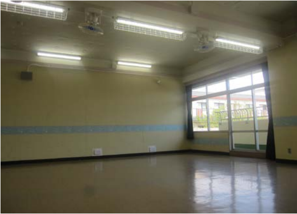
非構造部材耐震改修工事 大洲幼稚園
