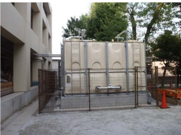
受水槽等改修工事 真間小学校
