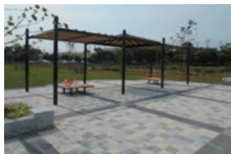
パーゴラ(公園休憩施設)
