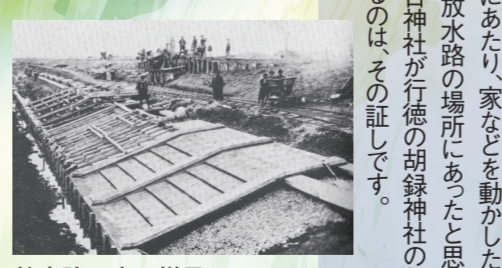
放水路工事の様子 (国土交通省 江戸川河川事務所提供)
