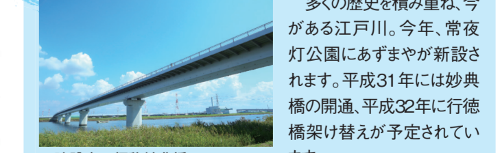
▲建設中の仮称妙典橋
