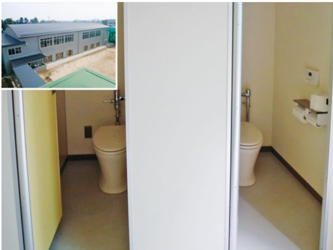
改修された第四中学校屋内運動場併設の外部用トイレ
