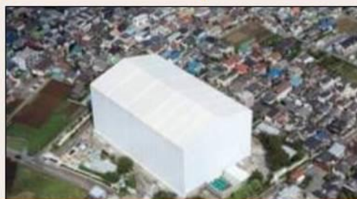
全覆い仮設テント等(解体工事中)
