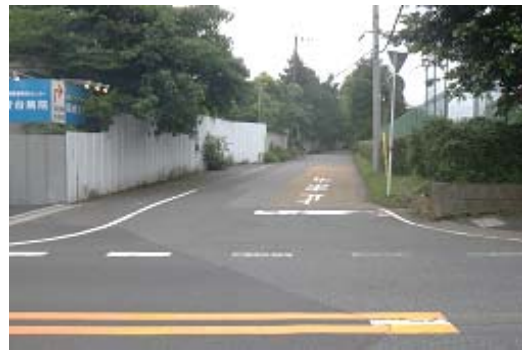
①公園北側に隣接する道路（公園園路）
