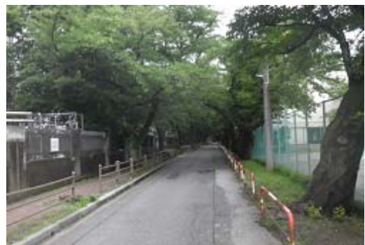
⑭ 公園南側に隣接する道路（公園園路）
