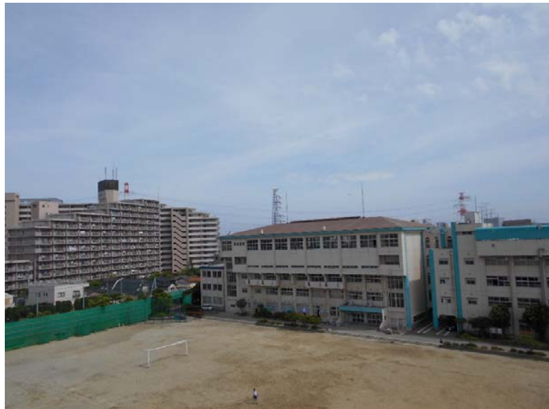
⑤校舎屋上より(南東側)
