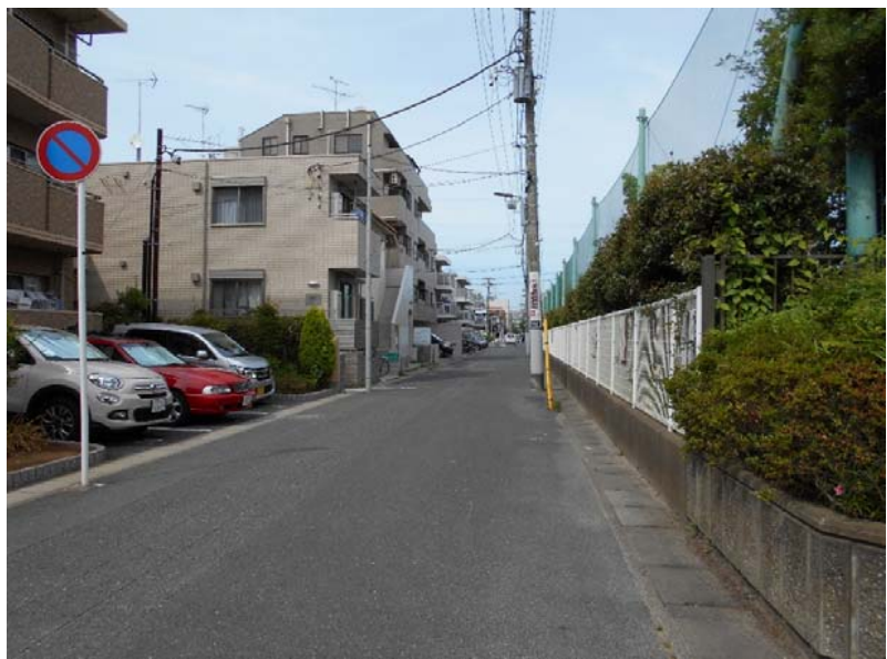
⑦北西側道路
