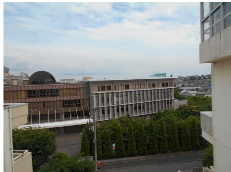
⑤校舎屋上より(南側)
