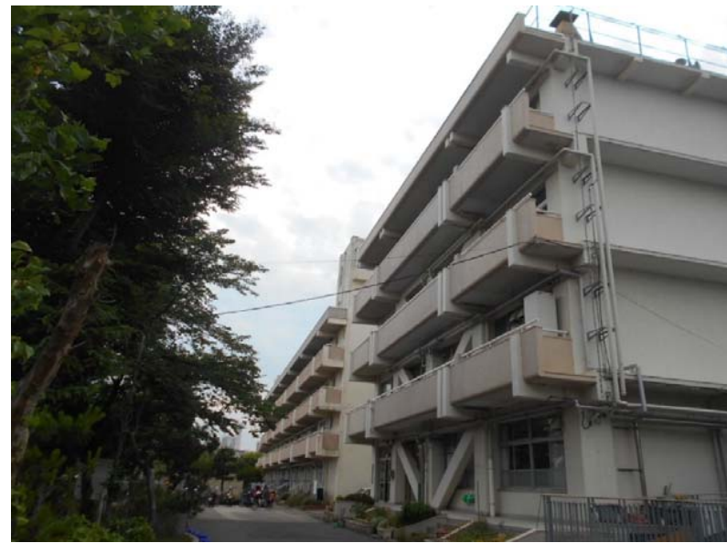
②北方小学校全景(南面)
