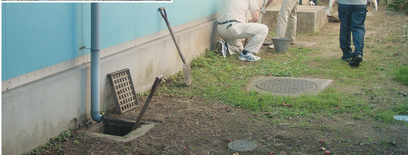
放射線量低減の取り組み 小学校での雨水ます清掃（左上）公園の表土の天地替え
