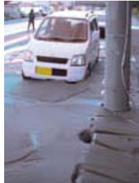
▲液状化現象により、道路に吹き出した砂(塩浜)
