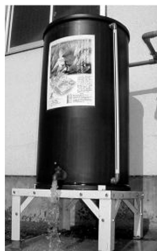
雨水貯留施設（雨どい取付型）
