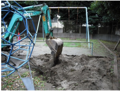
重機による土の掘り起こし
