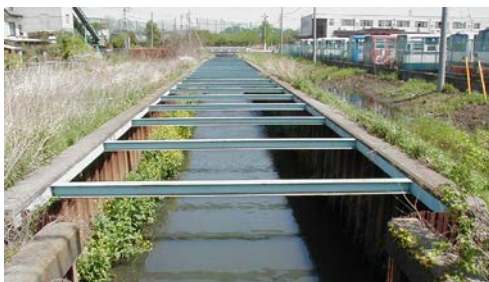
整備前：鋼矢板護岸
