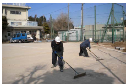
校庭表土の除去
