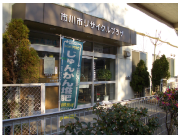
市川市リサイクルプラザ
