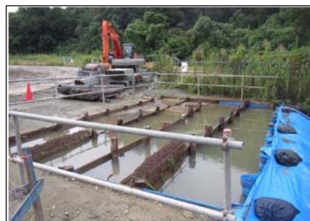
仮設沈砂池の例
