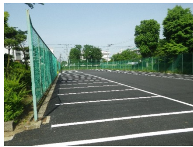
㉑北側駐車場（旧テニスコート）
