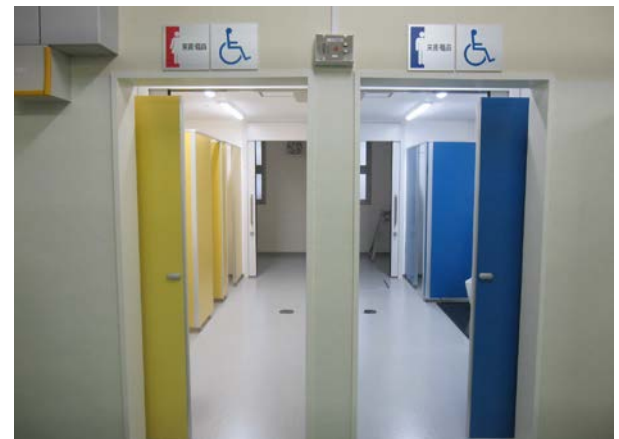
トイレ改修工事 富美浜小学校
