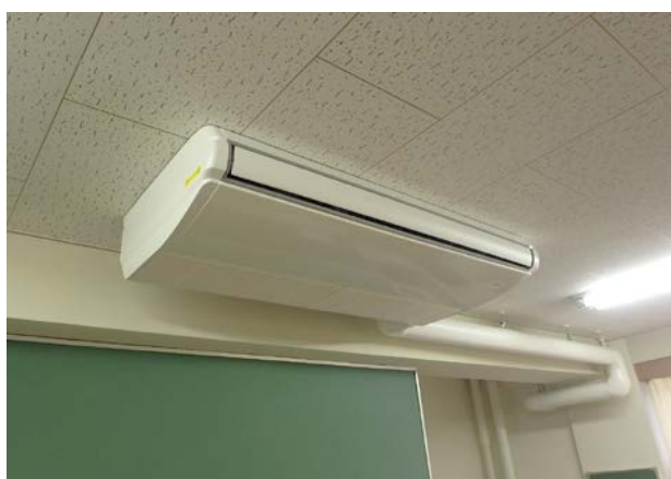
冷暖房機設置工事 鶴指小学校
