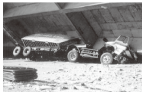
高速道路が倒壊した状況
