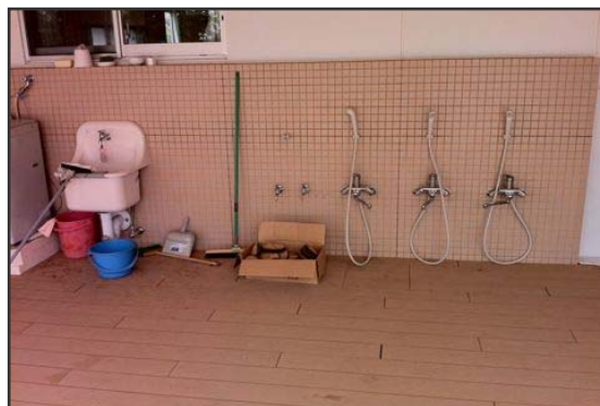
屋上デッキ 洗い場 ↑
