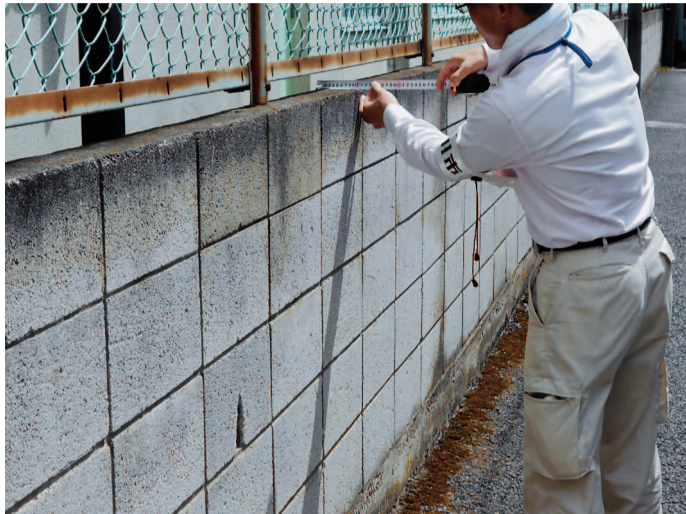
ブロック塀の安全点検調査
