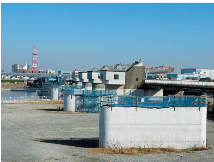
架け替え工事が進む行徳橋
