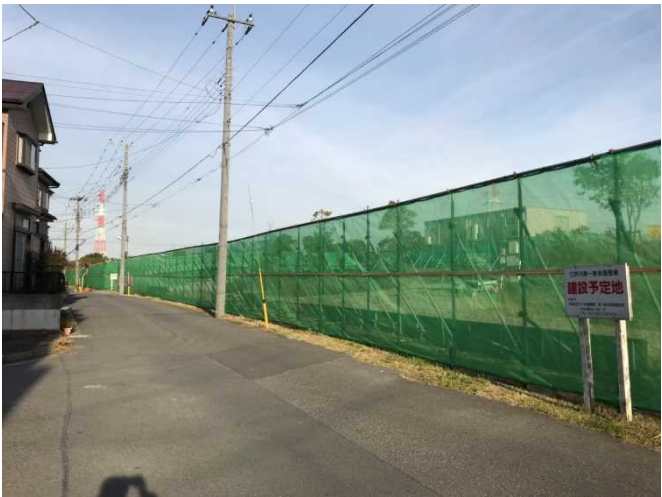
写真-3 防塵ネット設置状況
