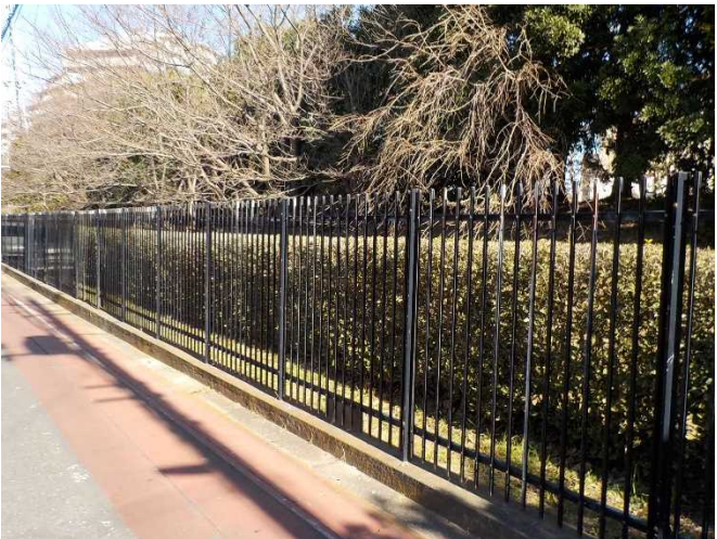
写真-4 (参考) 江戸川第二終末処理場の状況
