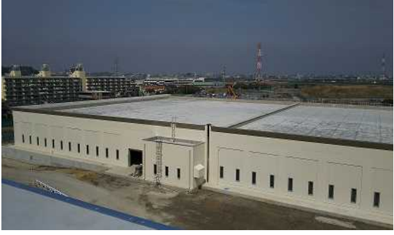
写真-6 水処理施設（高さ 約 8m）
