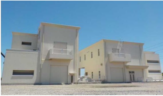
写真-5 主ポンプ棟（高さ 約 14m）
