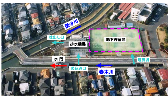
← 通常時の水の流れ ← 洪水時の水の流れ
