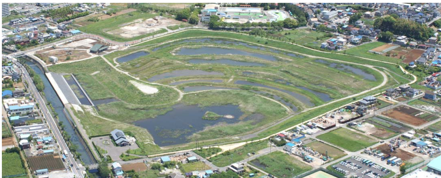
写真：大柏川第1調節池
