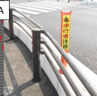
ラバーポールの設置 歩道橋付近の整備
