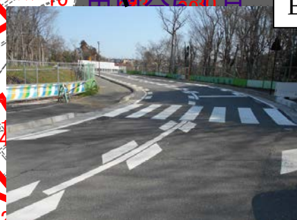
横断歩道の新設
