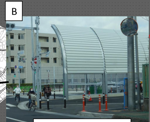
ラバーポールの設置 看板の設置
