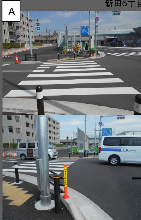
ポストコーン・看板の設置
