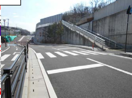
横断歩道の移設
