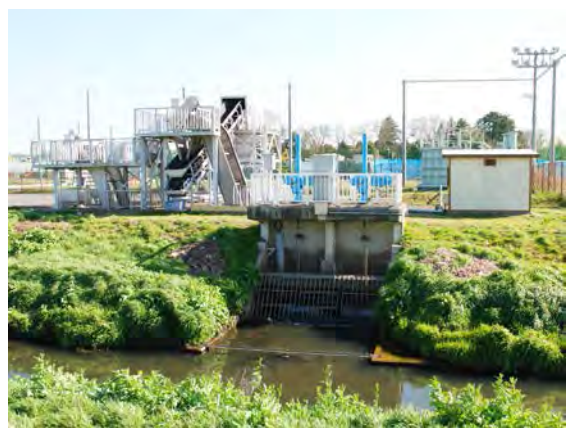
△河川浄化施設
