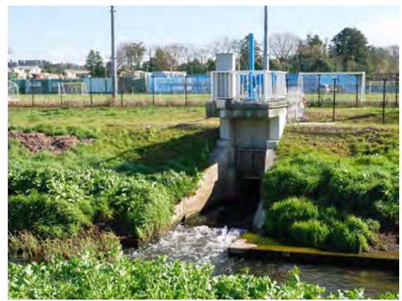
△河川浄化施設
