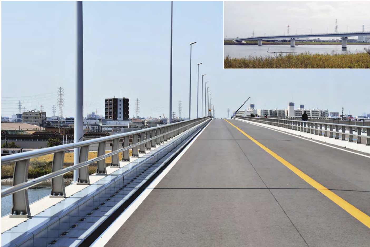
平成31年3月26日に開通した妙典橋。江戸川放水路を挟んだ高谷地区と妙典地区が結ばれ、市内東西方向の交通の分散化も期待される。
