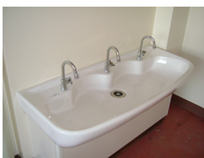
安全に配慮して、角に丸みをほどこした洗面台
