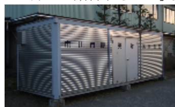
曾谷小体育館脇の備蓄倉庫
