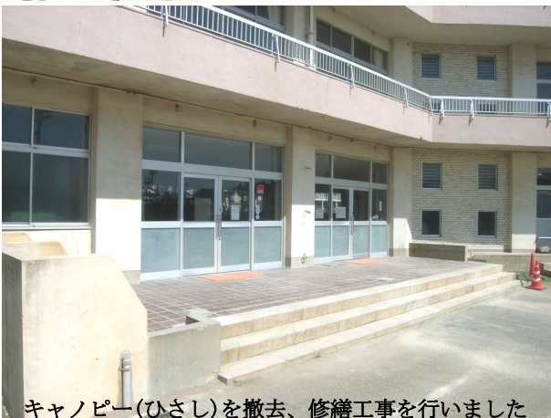
キャノピー(ひさし)を撤去、修繕工事を行いました
