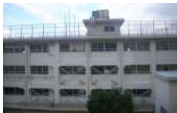
耐震補強工事が進む若宮小学校 校舎 (撮影日：平成25年9月26日)
