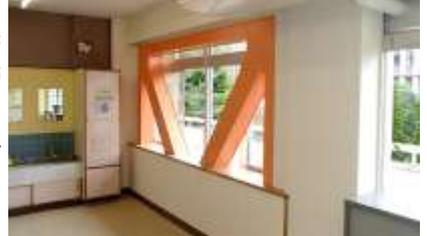
北方小学校校舎棟耐震補強工事 (平成26年度実施)
