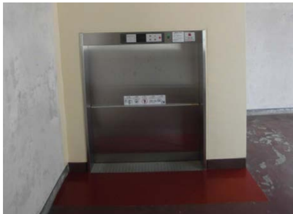
小荷物専用昇降機改修工事 北方小学校
