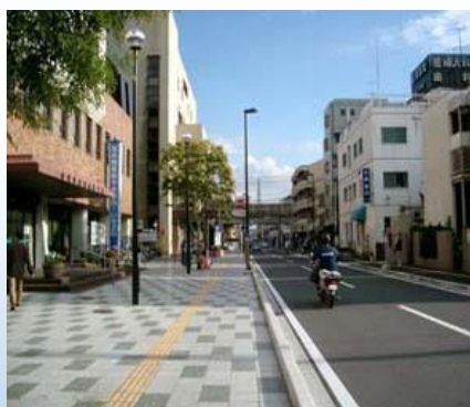
【バリアフリー化した歩道】
