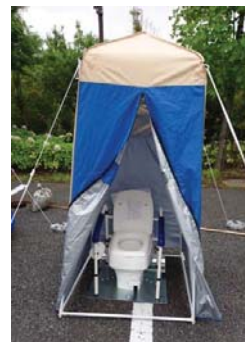
[マンホールトイレの設置] 7
