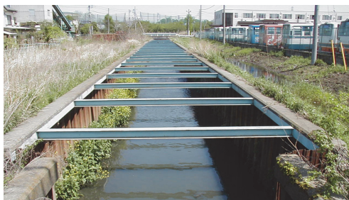
整備前：鋼矢板護岸
