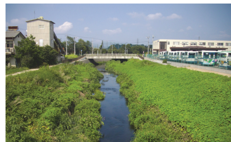
整備後：多自然型護岸
