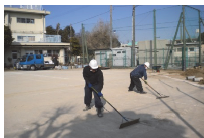
校庭表土の除去
