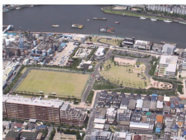
上空から見た広尾防災公園
