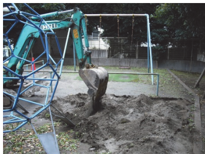
重機による土の掘り起こし
