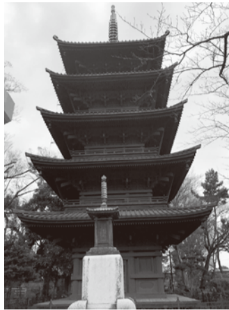
重要文化財の五重塔
