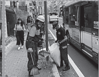
台風通過後、道路や側溝の清掃等を実施。
