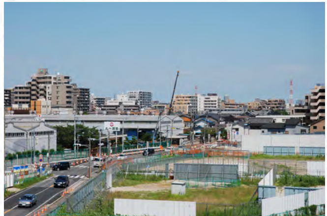
△新行徳橋の上から見た田尻の町並み
